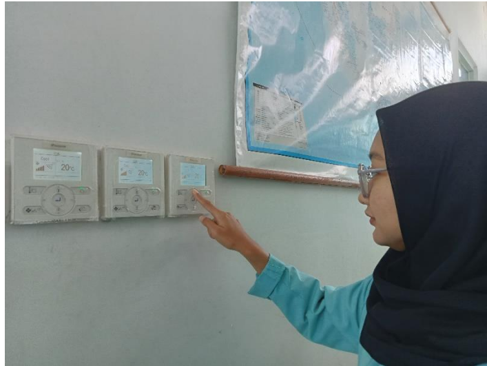
Sumber: Dokumentasi pribadi, 2024 Gambar 2.27. Tindakan Preventif dengan Mengatur Suhu Ruang
