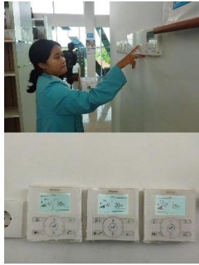
Gambar 2. 85 Mengatur suhu AC pada ruangan koleksi umum
